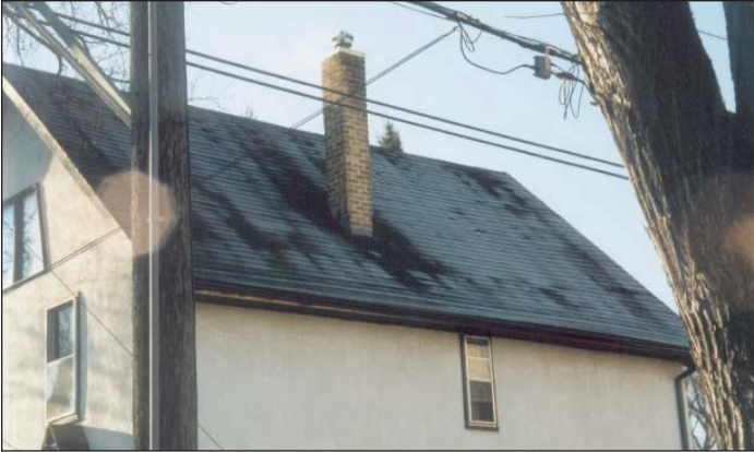
Exemple 4 Demi-étage montrant des différences d'épaisseur d'accumulation de neige
