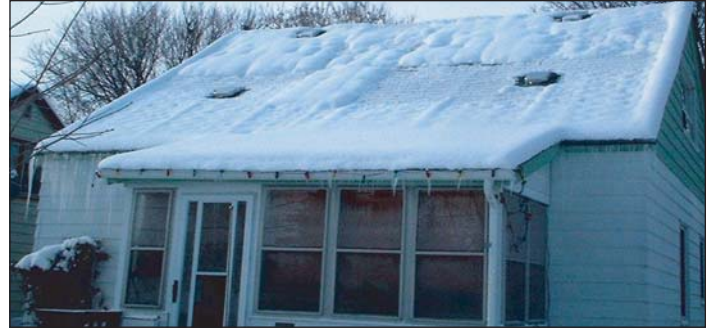
Exemple 4 Demi-étage montrant des différences d'épaisseur d'accumulation de neige
