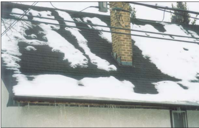
Exemple 2 Schémas de fonte dans des endroits particuliers
