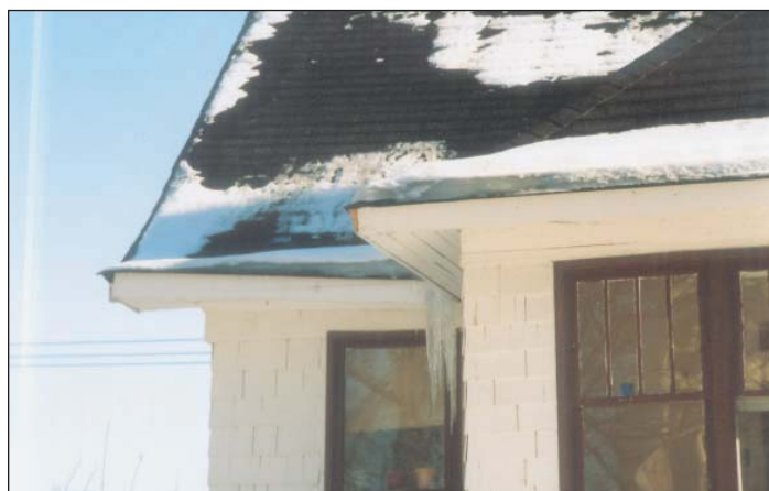
Exemple 1 Schémas courants de fonte sur des couvertures d'un demi-étage
