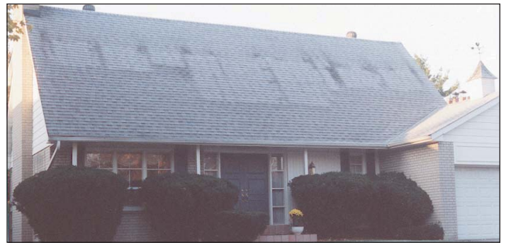
Exemple 5 Schéma de fonte du givre et niveaux d'isolation
