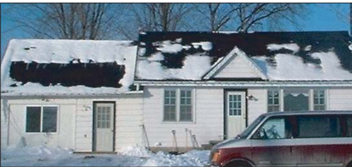
Exemple 3 Mur nain et schémas de fonte
